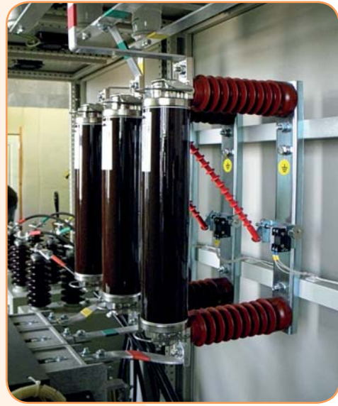
Установка внутренних держателей предохранителей*
