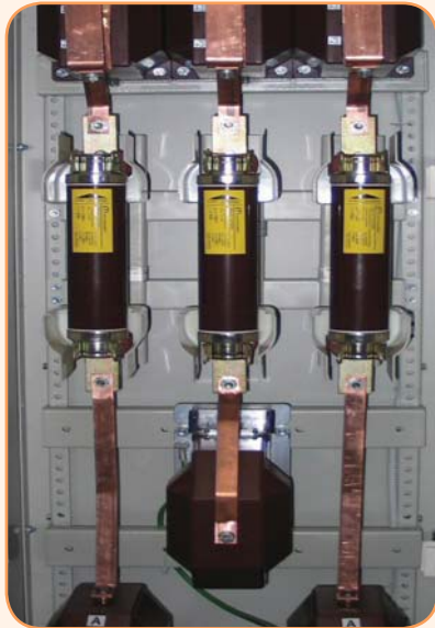
Внутренняя установка предохранителей
